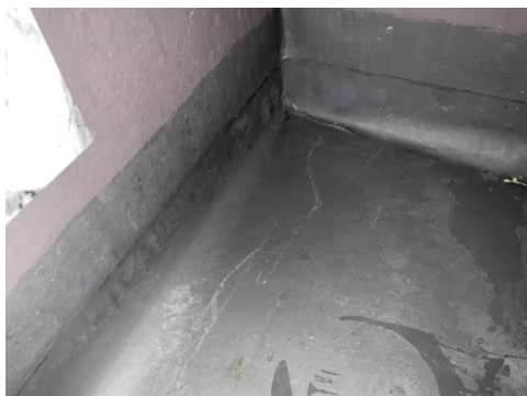
Sprekker på belegg/membran TG 3.
