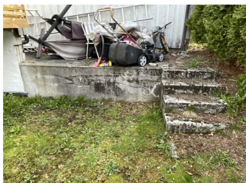
Støttemur ved garasje.
