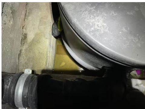
Det registeret vann under plast-tank TG 3.
