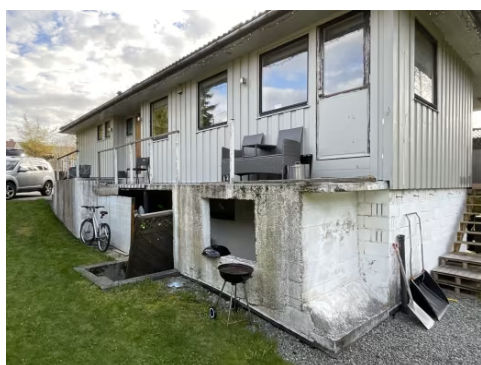
Støttemur/platting ved inngang.
