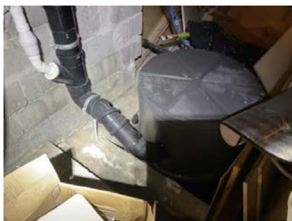
Avløp går til innvendig tank i plast.
