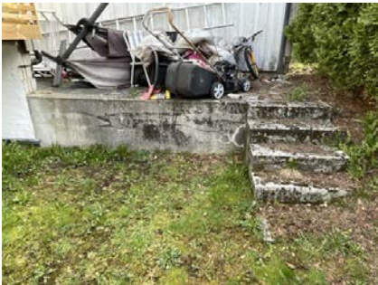
Støttemur ved garasje.
