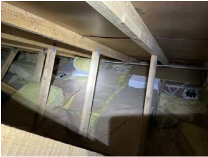
Flere koblinger/høytalere ligger åpen på loft og isolasjon mangler.
