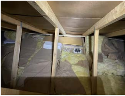
Flere koblinger/høytalere ligger åpen på loft og isolasjon mangler.
