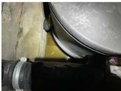
Det registrert vann under plast-tank TG 3.
