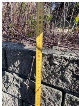
Åpning innvendig rekkverk trapp over 10 cm
