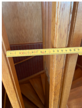
Åpning innvendig rekkverk trapp over 10 cm
