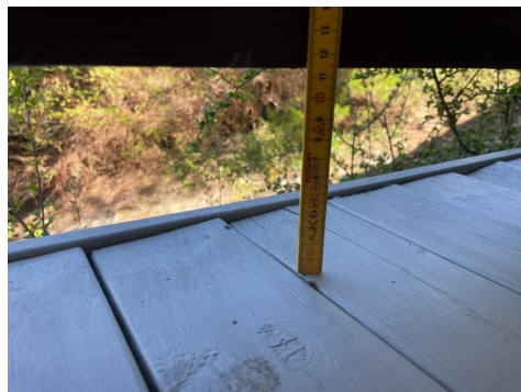
Åpning over 10 cm horisontalt rekkverk veranda
