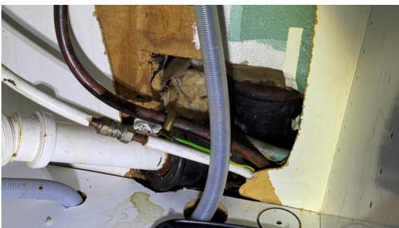
Eldre avløpsrør av soil.
