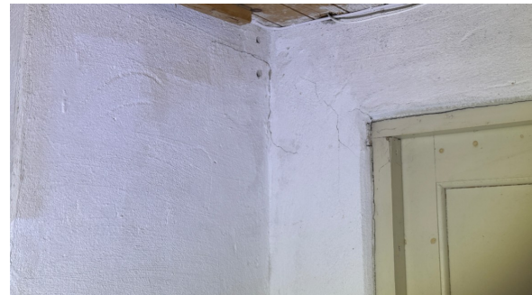
Grunnmuren har sprekkdannelser.
