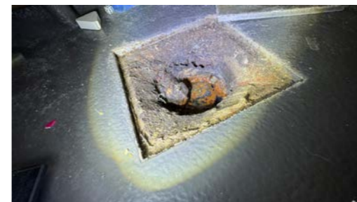
Kontroll av sluk.
