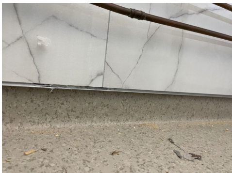
Manglende fugemasse
