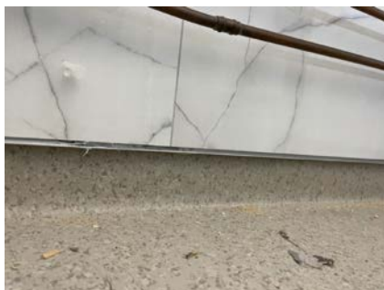
Manglende fugemasse
