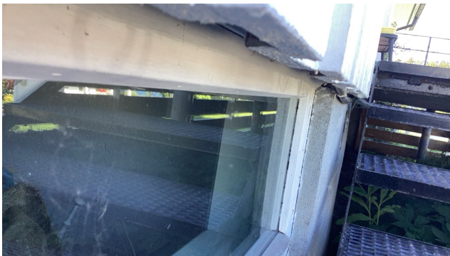
Foto viser nedkant av stående utvendig trepanel som ikke er skrånkjært
