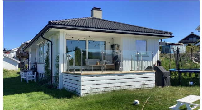
Oversiktsfoto av veranda med glass-rekkverk.
