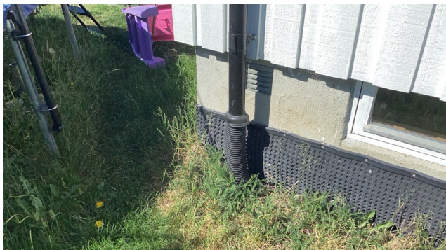
Foto viser at takrenne-nedløpet/takvannet fra hoved-taket blir ledet til rør.
