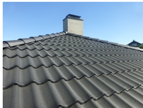
Oversiktsfoto av taktekket.
