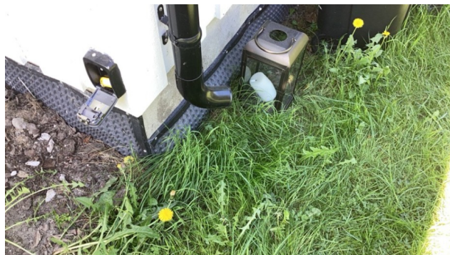
Foto viser takrenne-nedløp som avsluttes med utkaster ved grunnmuren.
