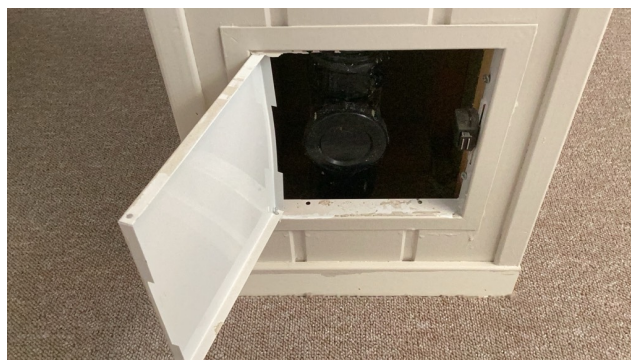
Foto viser stakeluke i plast/pvc-materiale.
