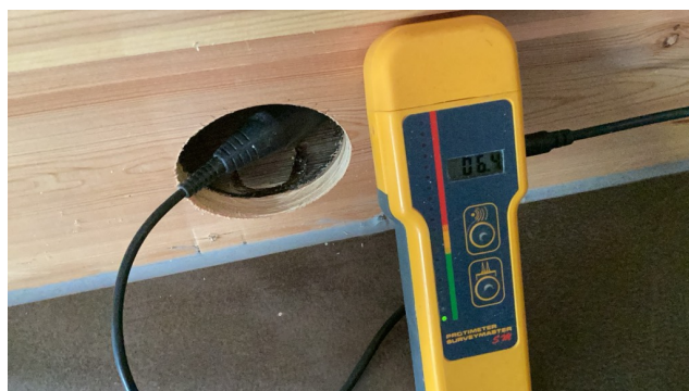
Foto viser fuktmåling ved innstikk av elektrodene i bunnsvillen i vegg. Målingene viste ikke forhøyet fuktighet, ca 6-7 % fukt-kvot.
