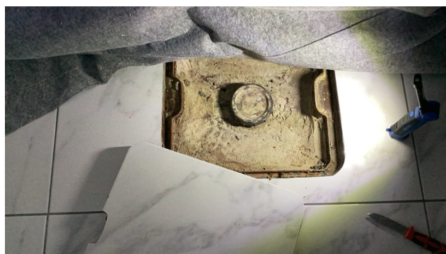
Foto viser luke i gulvet i kjellerstuen/allrommet hvor det er montert stakeluke.
