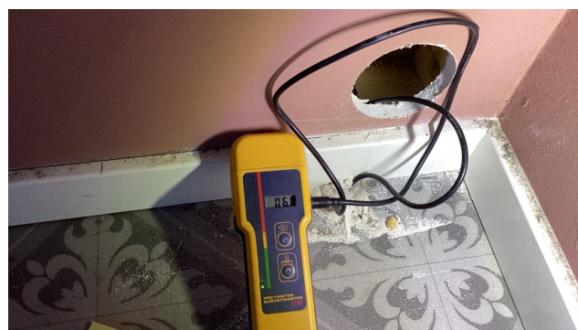
Foto viser måling med fuktindikator ved innstikk av elektrodene i bunnsvillen i vegg ikke viser forhøyet fuktighet, ca 6-7 % fukt-kvote.
