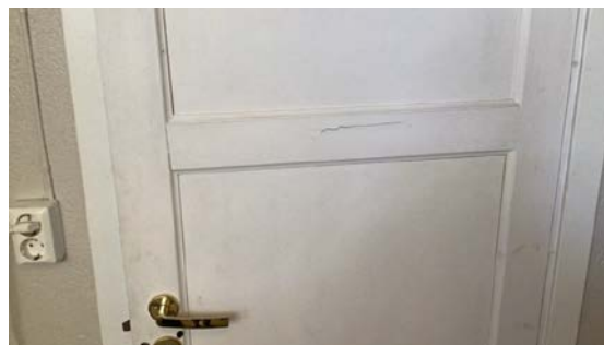
Foto viser dørblad med spekk.
