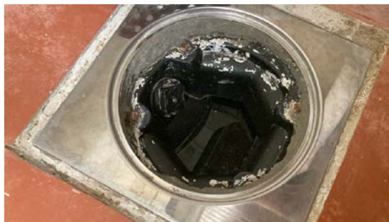
Foto viser ingen synlig membran i sluket
