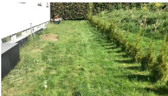
Foto viser terreng som stedvis skråner ned mot bygningen.
