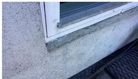
Foto viser lite gunstig innpusning av kjellervindu.
