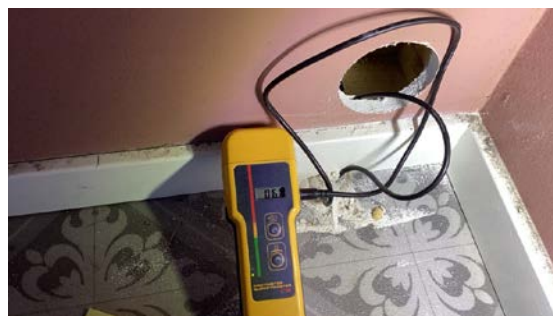
Foto viser måling med fuktindikator ved innstikk av elektrodene i bunnsvillen i vegg ikke viser forhøyet fuktighet, ca 6-7 % fukt-kvot.
