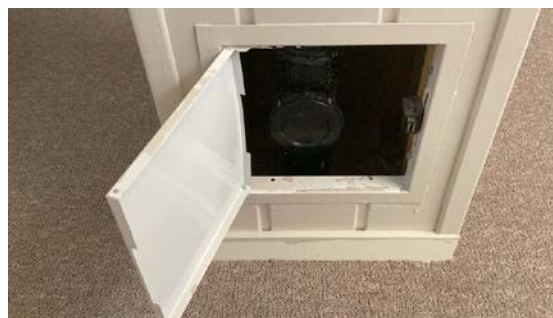
Foto viser stakeluke i plast/pvc-materiale.
