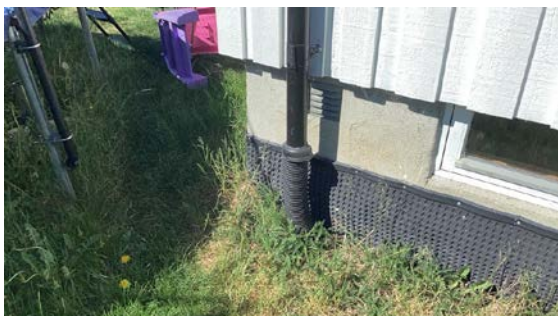
Foto viser at takrenne-nedløpet/takvannet fra hoved-taket blir ledet til rør.
