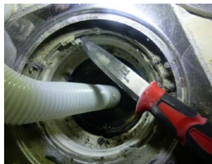
Foto viser knivspiss som peker på synlig del av membran/slukmansjett ved klemringen i sluket
