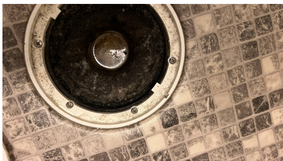
Sluk på vaskerommet
