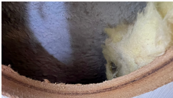
Fuktmåling i vegg mot terreng.
