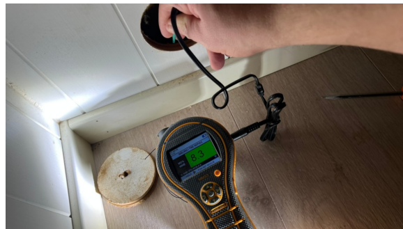
Fuktmåling i vegg mot terreng.
