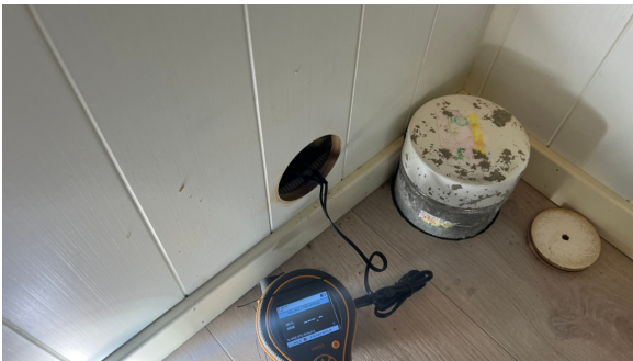
Fuktmåling i vegg mot badet
