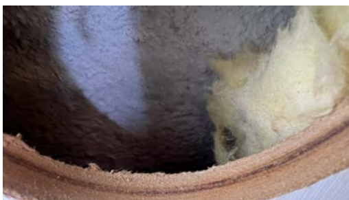
Fuktmåling i vegg mot terreng.
