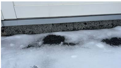
Grunnmuren under balkongdør.
