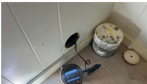
Fuktmåling i vegg mot badet
