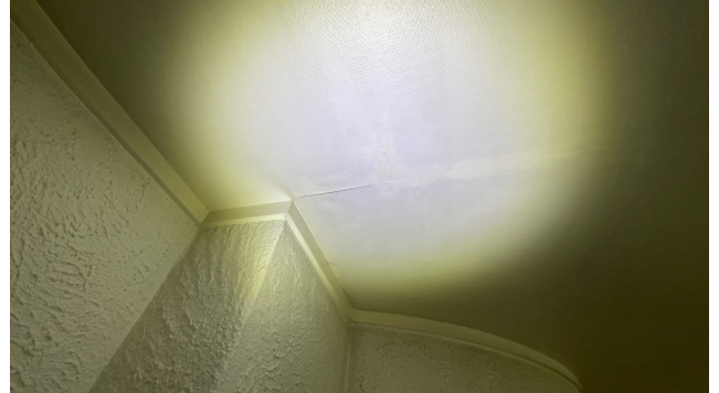
Riss/løsning strieskjøt
