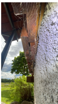
Panel er luftet med tynnere sløyfelekt.
