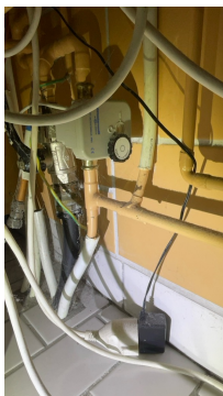
Vannstoppventil- ikke fast stikkontakt
