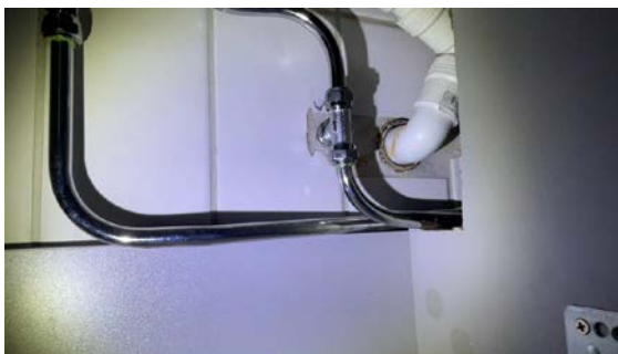
Rørgjennomføring servant
