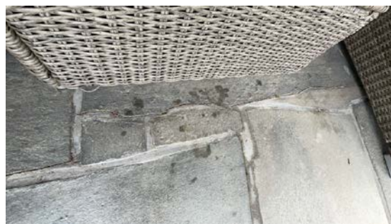
Sprekk fuger
