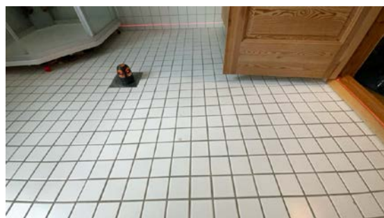
Fallnivellering
