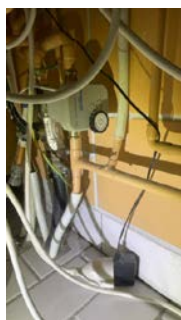
Vannstoppventil- ikke fast stikkontakt
