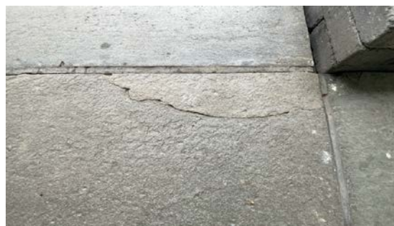
Sprekk flis
