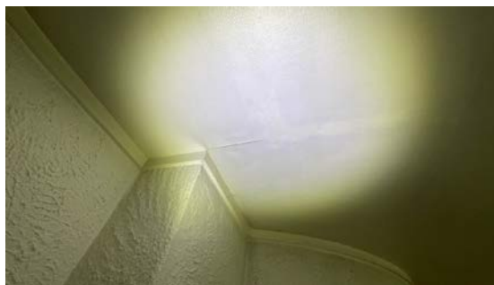
Riss/løsning strieskjøt
