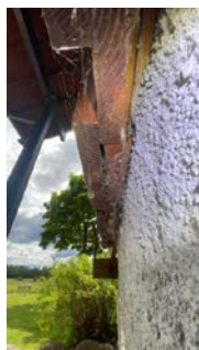
Panel er luftet med tynnere sløyfelekt.
