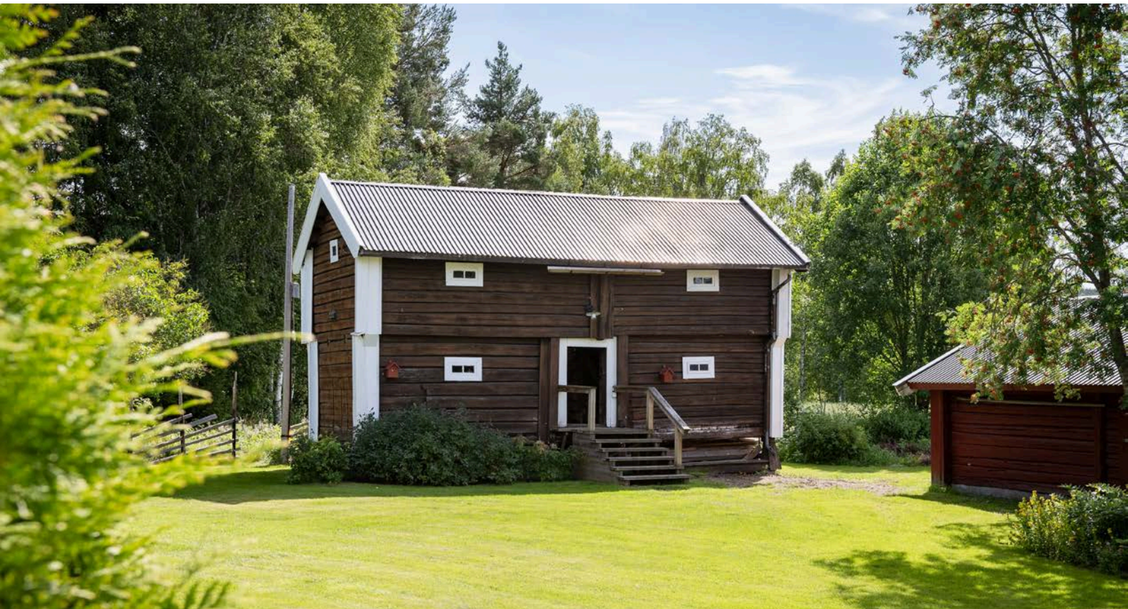
Stabburet har et bruksareal på 43m 2 og består av lagerrom over to plan.
