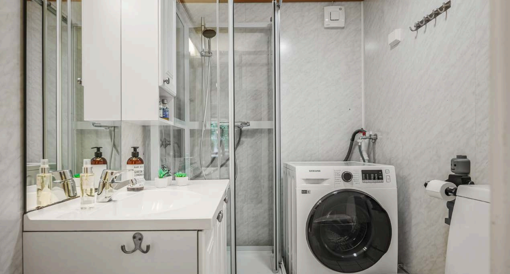
Eldre bad/vaskerom i 2. etasje med flislagt gulv med gulvvarme, våtromsplater på veggene og elvifte.
