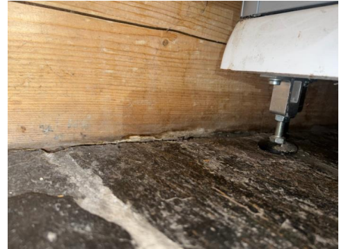
Ikke tettesjikt i vegg/våtsone
