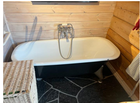
Ikke tettesjikt i vegg/våtsone
