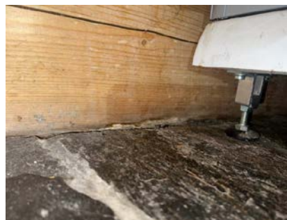
Ikke tettesjikt i vegg/våtsone
