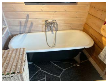
Ikke tettesjikt i vegg/våtsone
