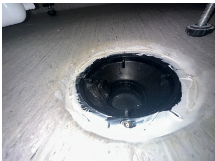
Sluk i plast, plassert i dusjnisje
