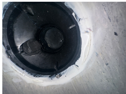
Sluk i plast, plassert i dusjnisje
