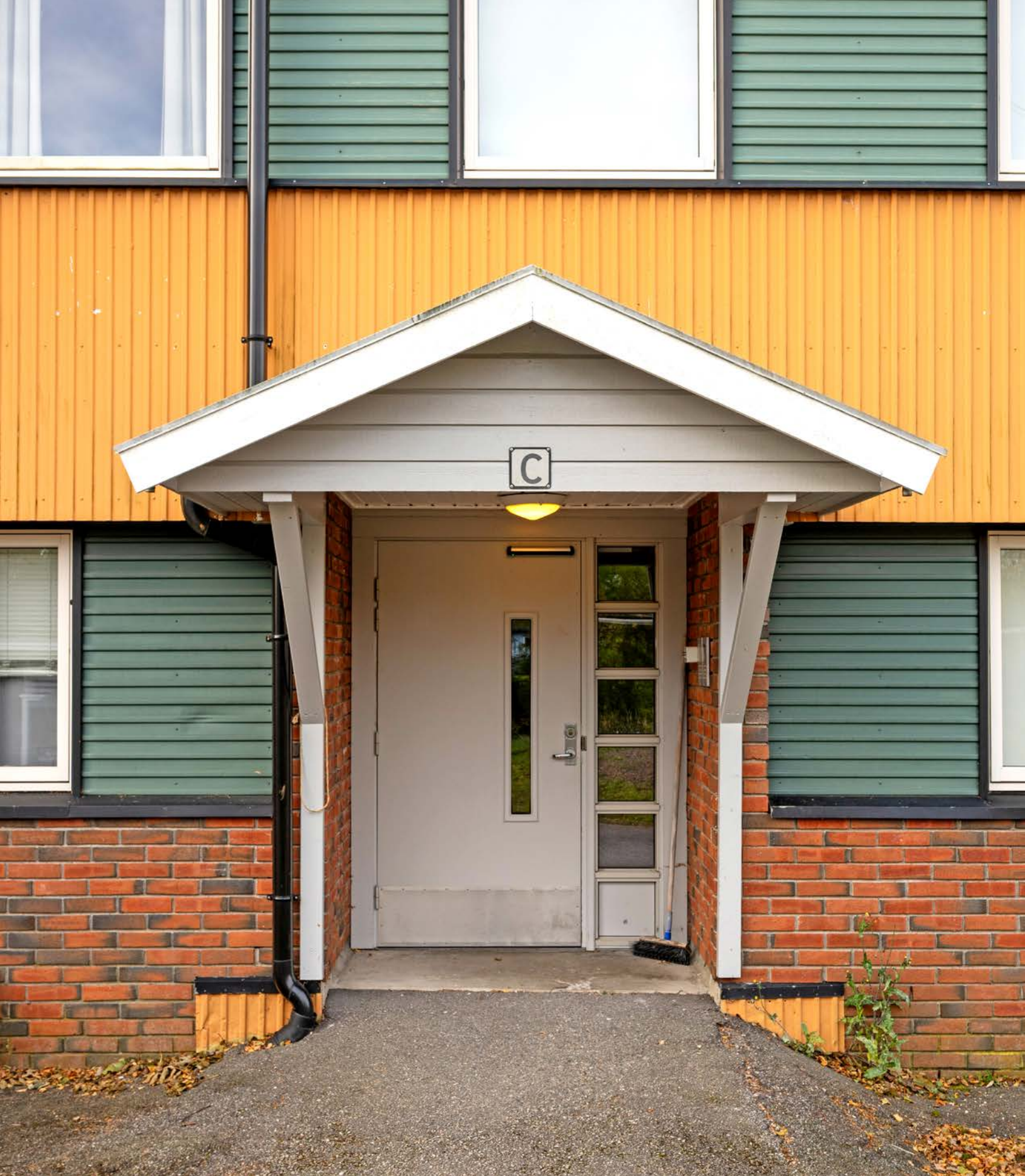
Felles inngangsparti med dørcalling. Trapp ned til underetasjen til leiligheten.
