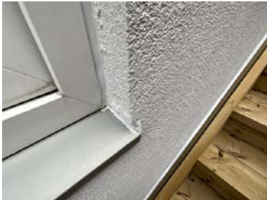
Beslag er montert, utskifting av fug ved behov.
