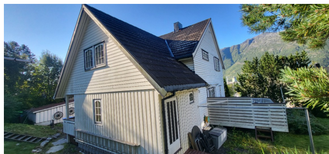
Stående kledning på tilbygg.
