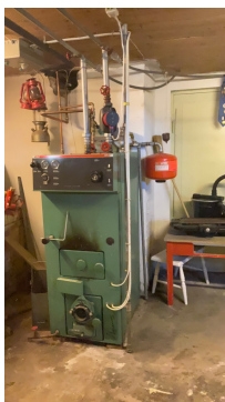
Gammel oljebrenner som brukes som varmvassbereder.
