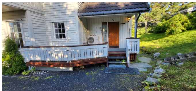
Terrasse ved inngang.
