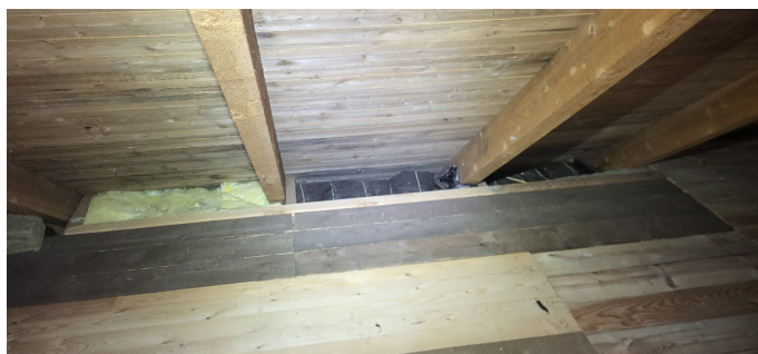
Isolering ved raft med mineralull og sydde matter.
