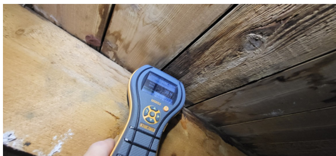
Fuktmåling i tro uten å påvise forhøyede fuktverdier.
