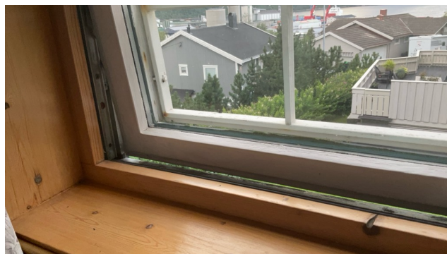
Fuktskadet vindu.
