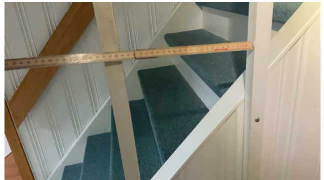
Åpninger i rekkverk skal inntil en høyde på 0,75 m i trappeløpet være maksimum 0,10 m.
