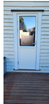
Terrassedør ut fra stue fra 2019.
