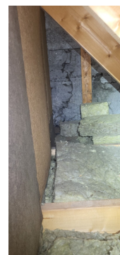
Kontroll i knevegg gjennom luke.
