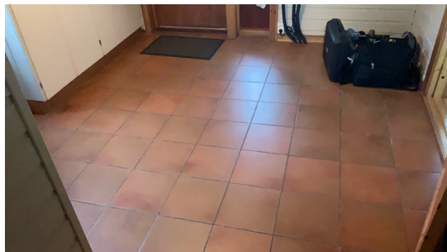
Bom under fliser og fuger er sprukket.
