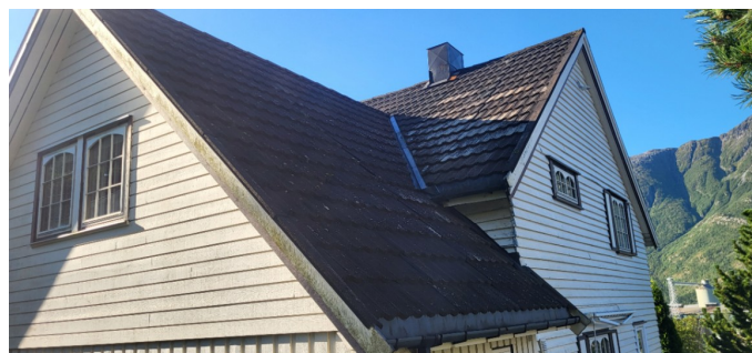
Slitasje på overflate på takplater.
