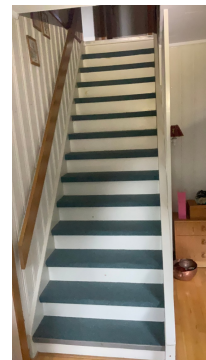
Åpninger i rekkverk skal inntil en høyde på 0,75 m i trappeløpet være maksimum 0,10 m.
