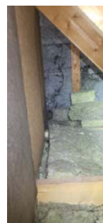
Kontroll i knevegg gjennom luke.
