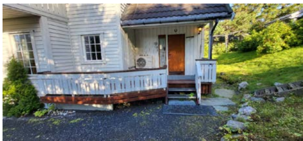
Terrasse ved inngang.
