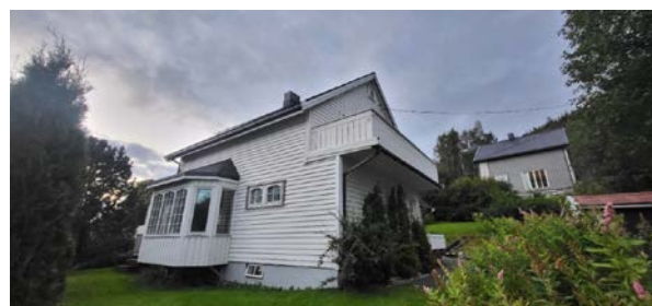
Terrasse over oppvarmet rom i stue og gang.
