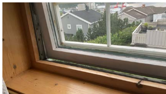
Fuktskadet vindu.
