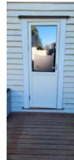
Terrassedør ut fra stue fra 2019.
