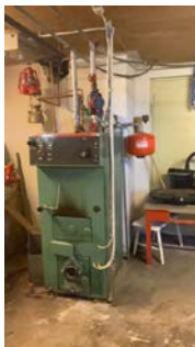
Gammel oljebrenner som brukes som varmvassbereder.
