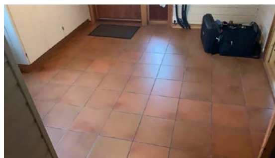
Bom under fliser og fuger er sprukket.
