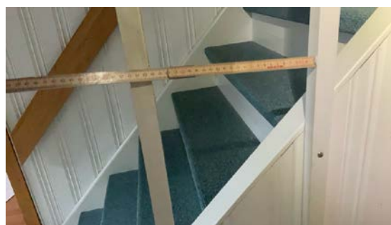
Åpninger i rekkverk skal inntil en høyde på 0,75 m i trappeløpet være maksimum 0,10 m.
