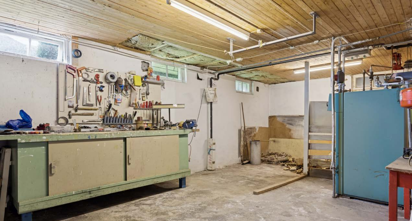
Bod/arbeidsrom i kjelleren
