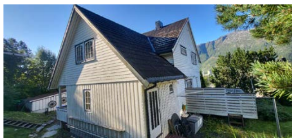
Stående kledning på tilbygg.
