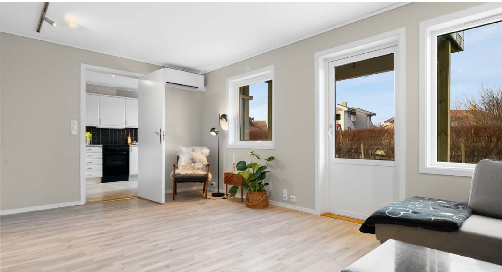
Stue med varmepumpe som er ny i 2026
