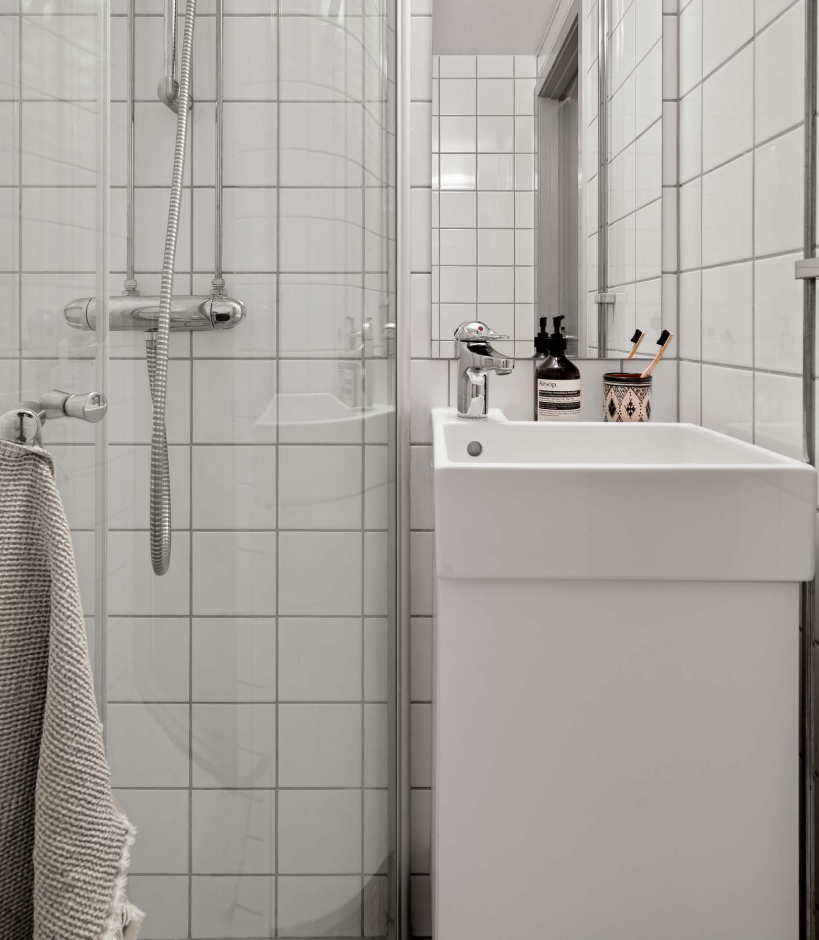
Badet ble rehabilitert i borettslagets regi i 2012/13 med bl.a nytt gulvsluk med klemring for foliemembran.
