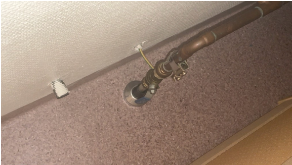
Stoppekran på teknisk rom.
