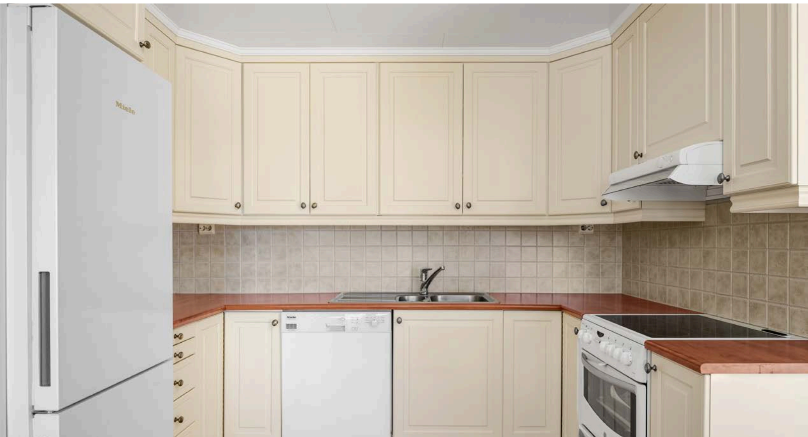
Kjøkkenventilatoren har avtrekk direkte ut og avsatt plass til frittstående hvitevarer.
