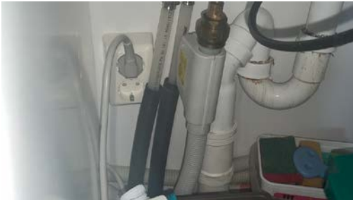
Stoppekran på teknisk rom.
