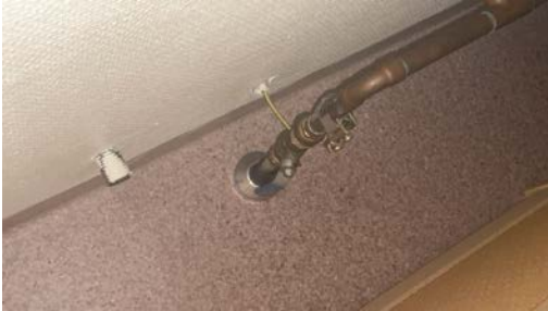
Stoppekran på teknisk rom.
