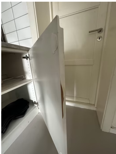
Dør antatt utsatt for varmgang fra stekeovn.
