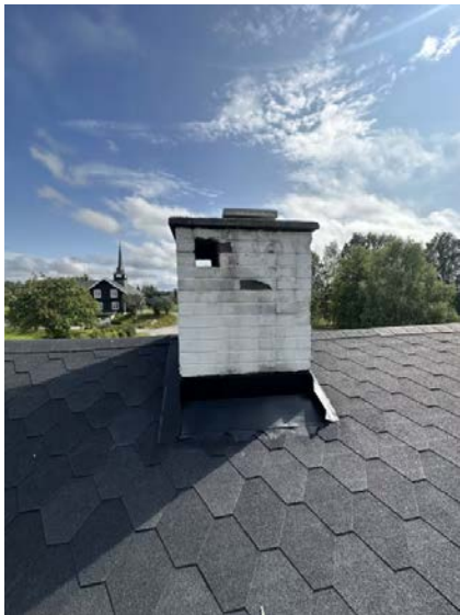
Viser beslagløsning ved pipe.
