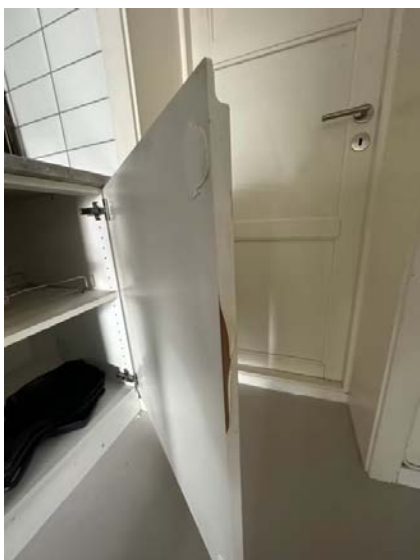
Dør antatt utsatt for varmgang fra stekeovn.
