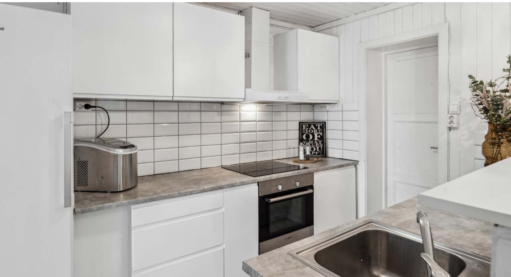
Kjøkkeninnredning av nyere dato med hvite glatte fronter, laminert benkeplate med nedfelt oppvaskum og fliser i benkeryggen.
