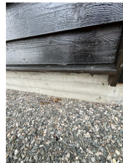
Liten skade i underkant av vannese.
