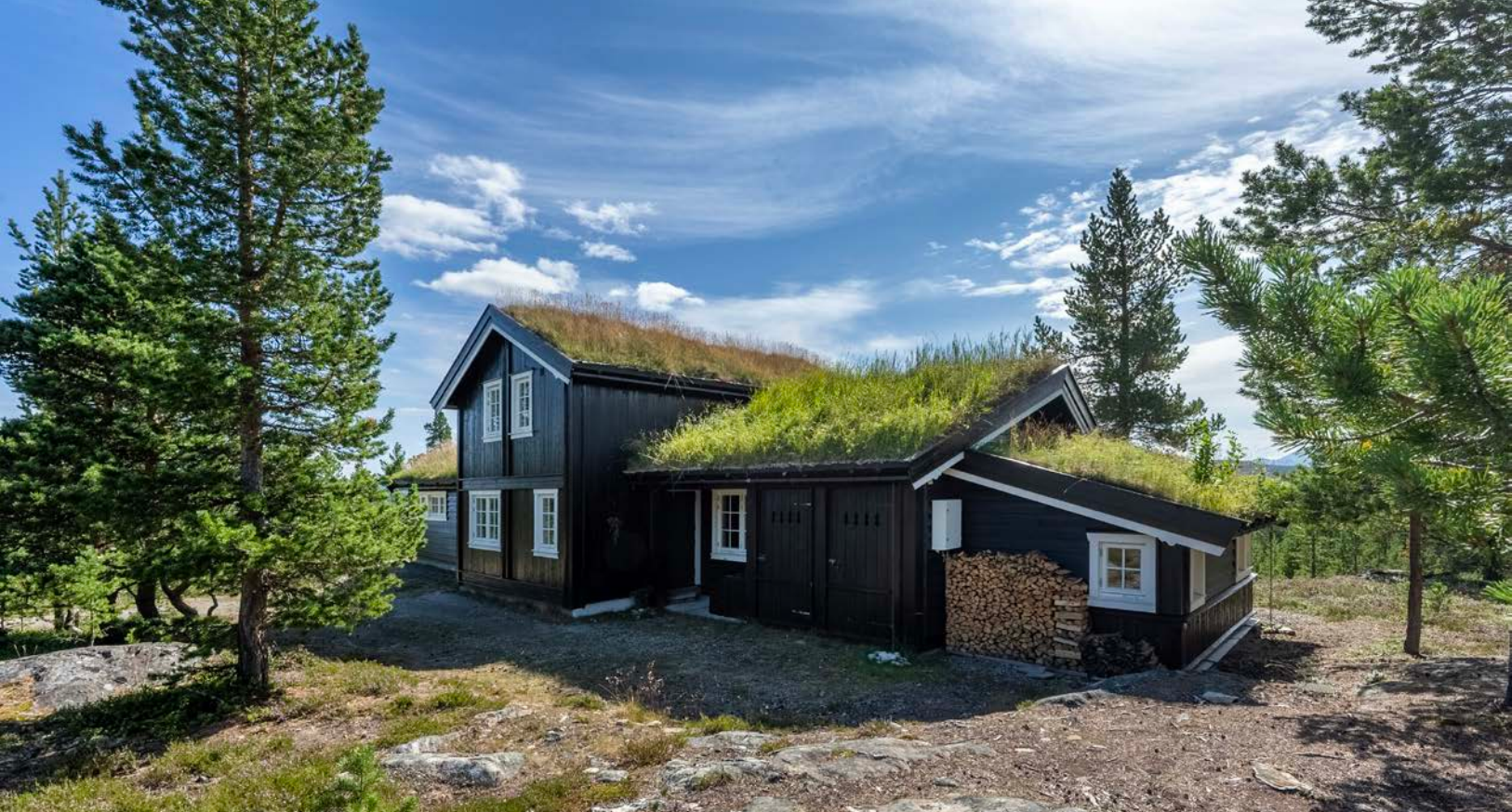
Fasade mot nord med takoverbygd inngangsparti og utvendig bod
