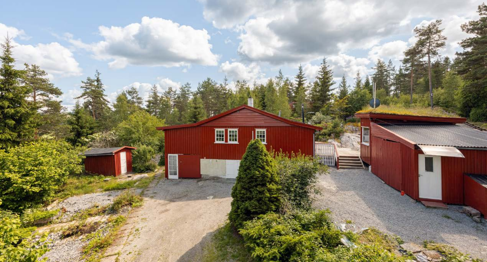
Hytta har en krypkjeller med utvendig adkomst fra gårdsplassen.
