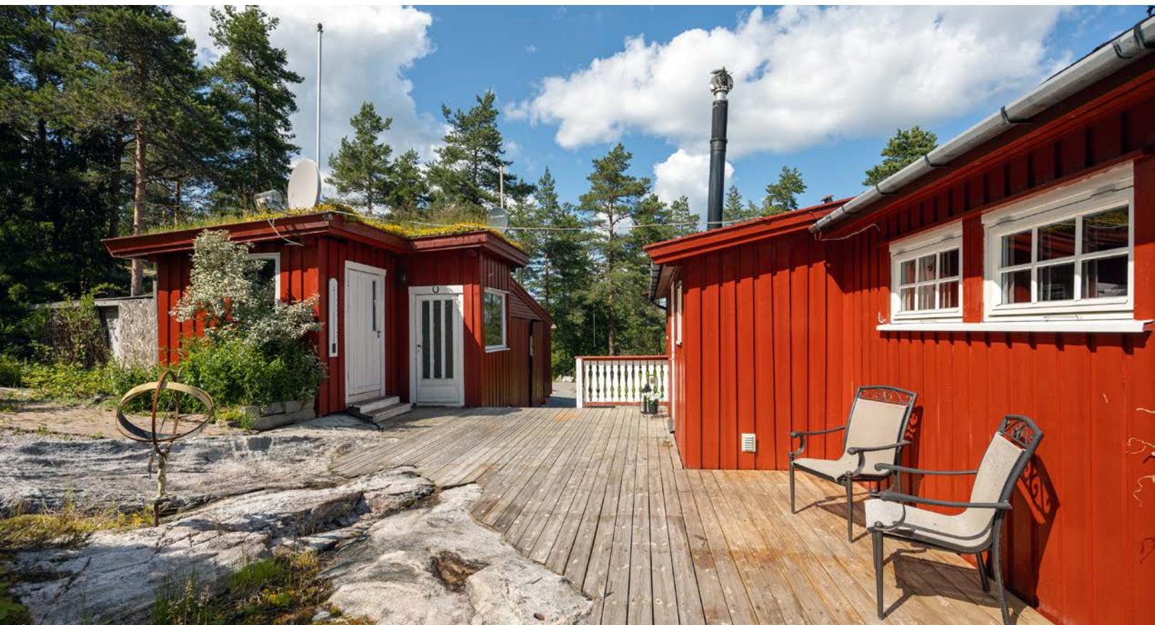
Ved inngangspartiet har hytta en markterrasse ved inngangen. Terrassen måler ca. 34 kvm og binder hytta sammen med et hendig uthus.
