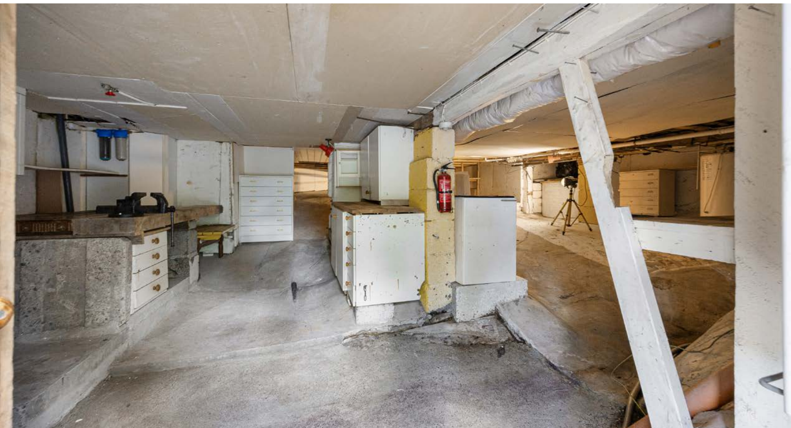
Grunnmuren er plassert på fjell, og det er sluk i grunn/gulv i krypkjeller. Varmtvannstanken er plassert i krypkjelleren.
