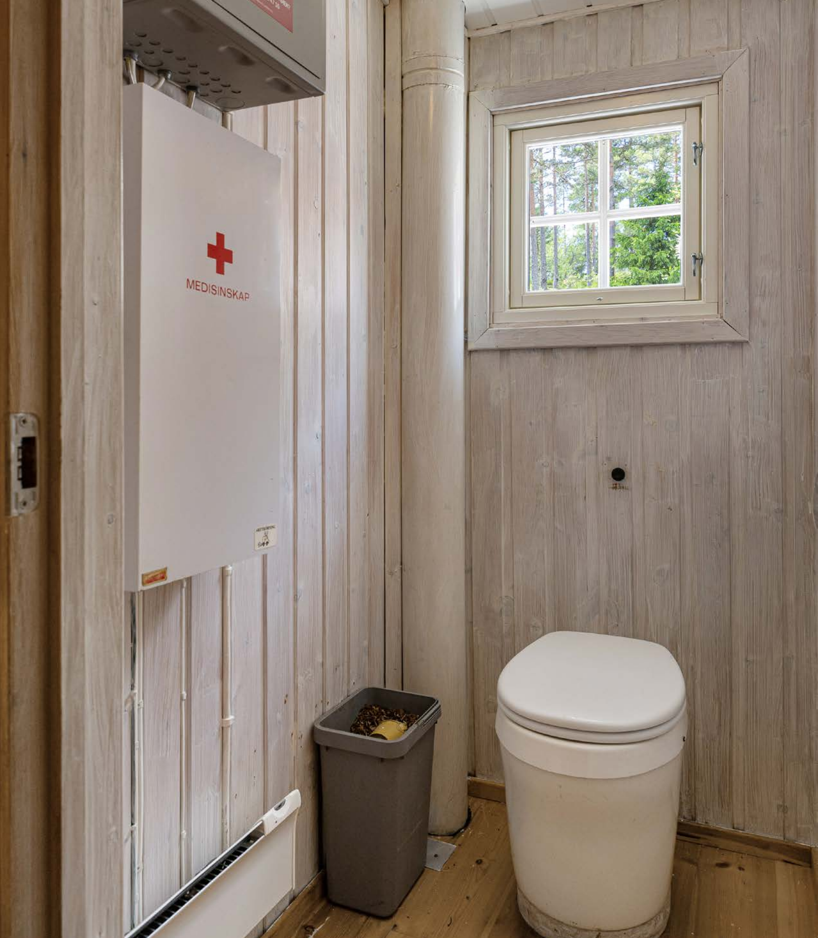
Wc-rommet er utstyrt med snurredo.
