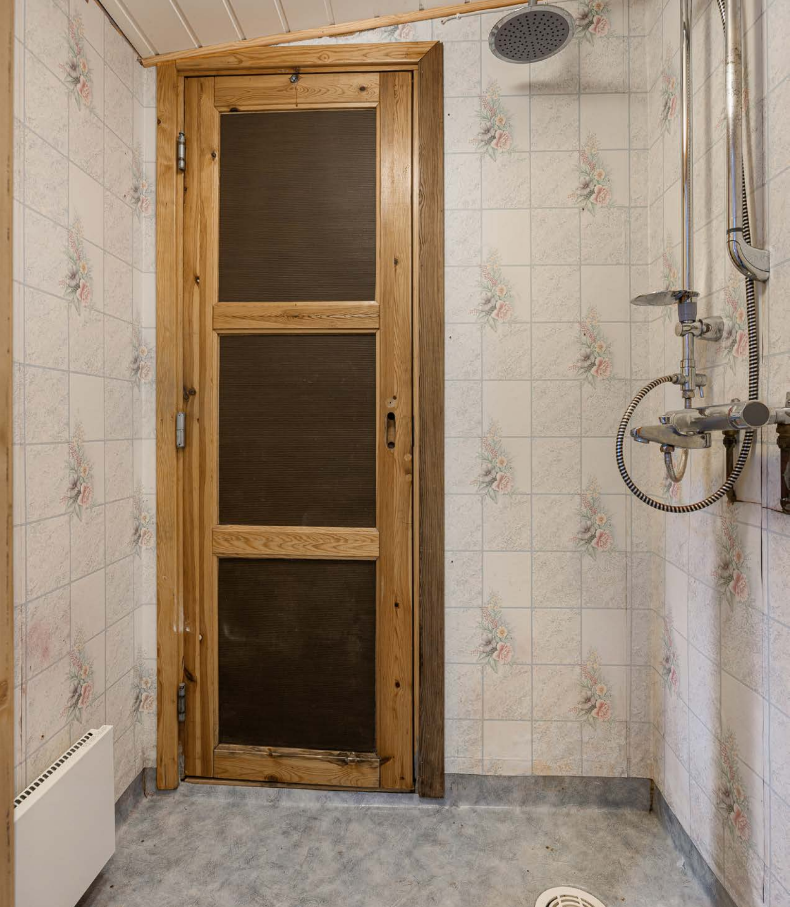
Dusjrommet har gulvbelegg og våtromstapet på veggene, panelovn, samt et åpent dusjhjørne.
