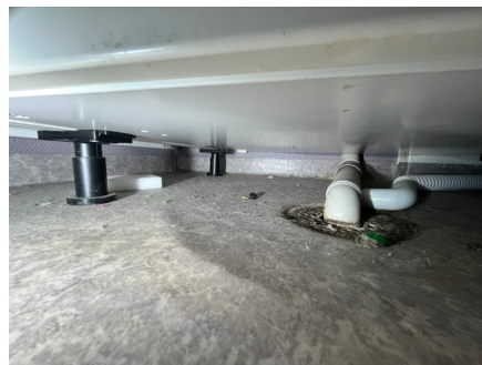
Kant der lokalt fall begynner er 2mm høyere enn gulv ved dør til gangen.
