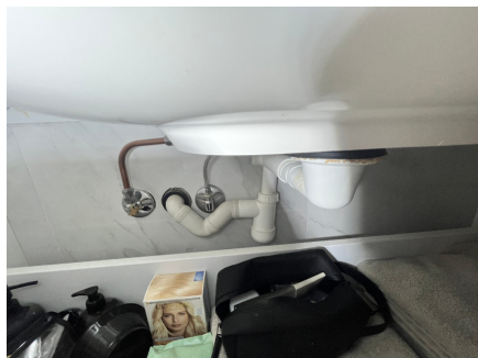
Tetting rundt rør i vegg
