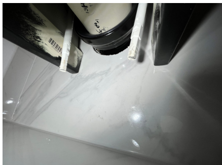
Tetting rundt rør i vegg
