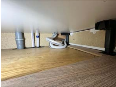
Laminat ovenpå opprinnelig gulv, 1 etg
