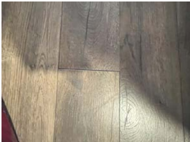
Laminat ovenpå opprinnelig gulv, 1 etg
