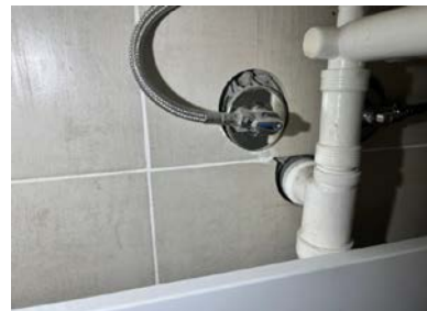
Tetting rundt rør i vegg
