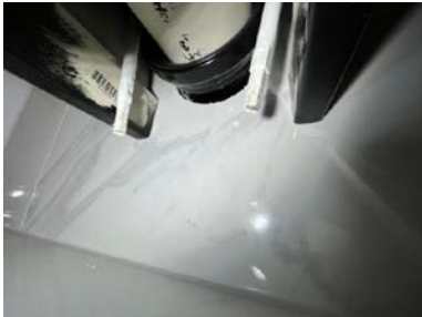
Tetting rundt rør i vegg
