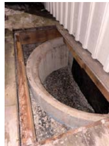
Luke i gulv for adkomst til krypekjeller.
