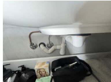
Tetting rundt rør i vegg
