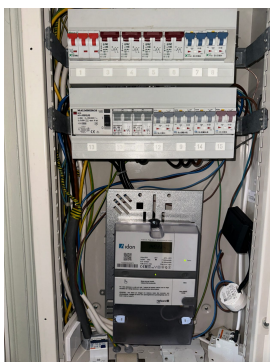
Sikringsskap med automatsikringer.
