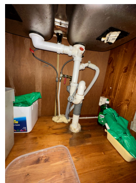
Rørapplegg med stoppekran i kjeller
