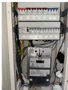
Sikringsskap med automatsikringer.
