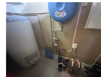
Samlestokk i bod under trapp.
