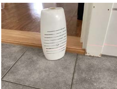
Ca 17 mm høydeforskjell fra topp slukrist til gulv ved terskel.
