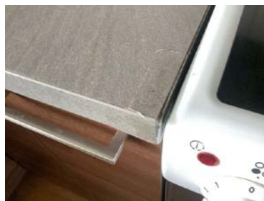
Skade i benkeplate ved komfyr.
