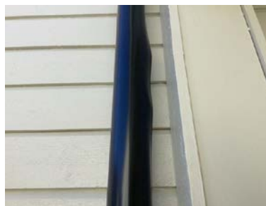
Frostsprenget nedløp.
