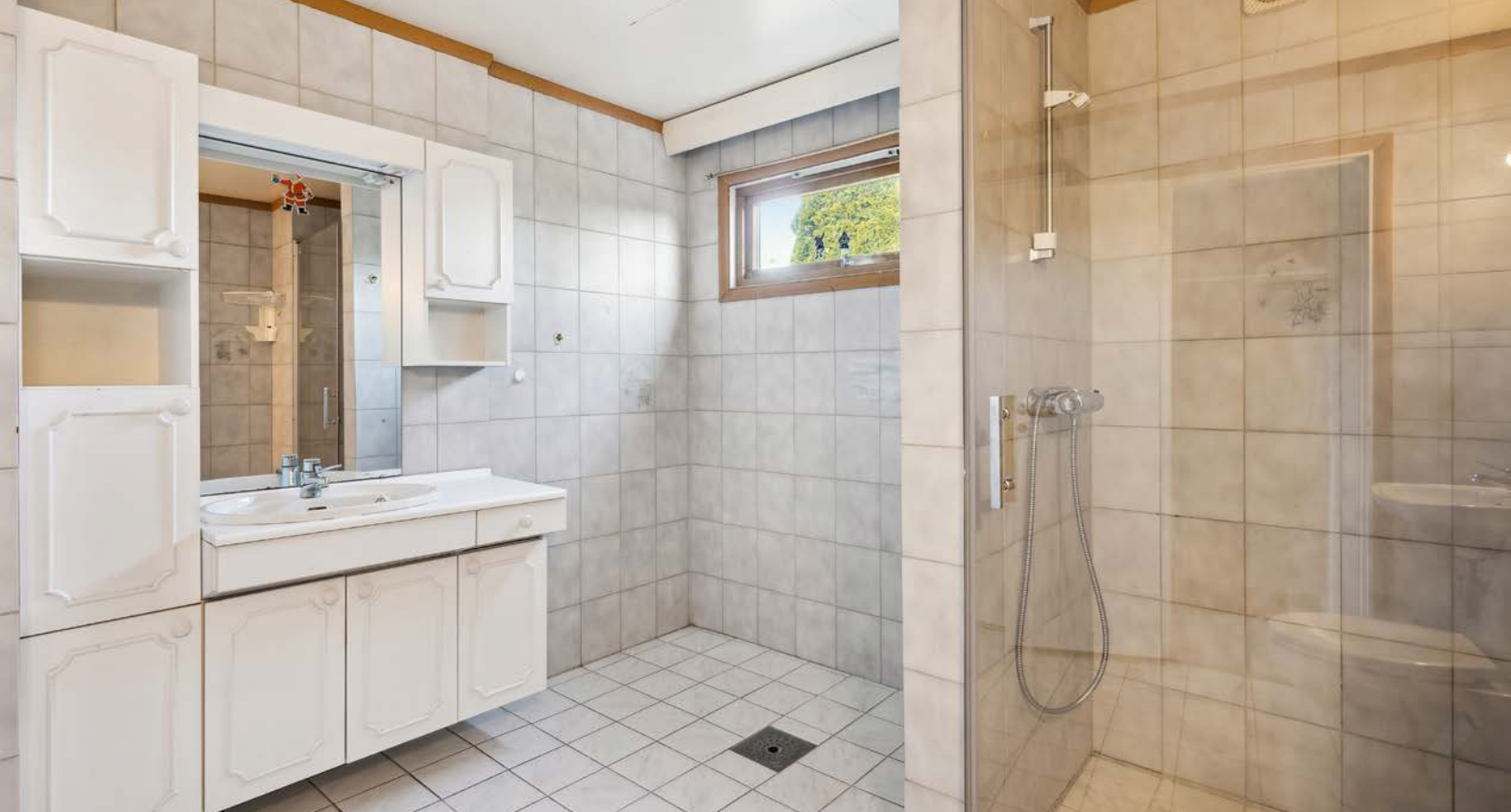
Flislagt bad fra 1985.
