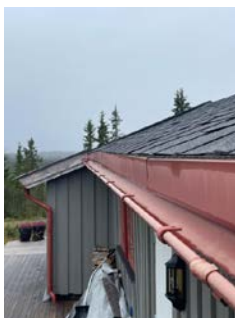
Ufaglig løsning mellom beslag og motfall på renne
