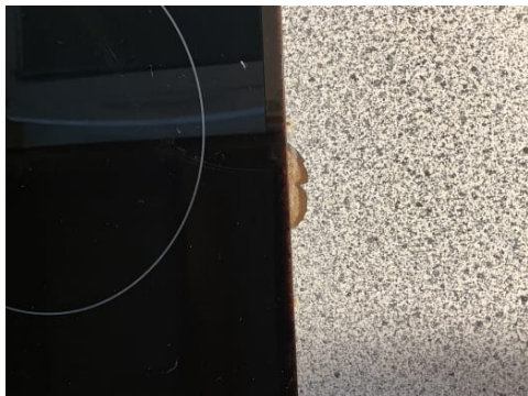
Viser avskalling på benkeplate
