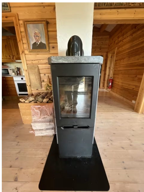
Viser ildsted montert i stue.
