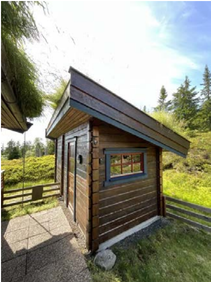
Viser frittstående uthus/vedbod
