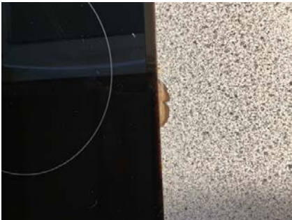
Viser avskalling på benkeplate
