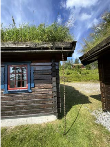
Viser trestakrenner og nedløp med kjetting.
