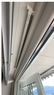
Eksempel på montert ventil i vindu.
