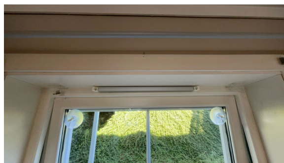
Eksempel på montert ventil i vindu.
