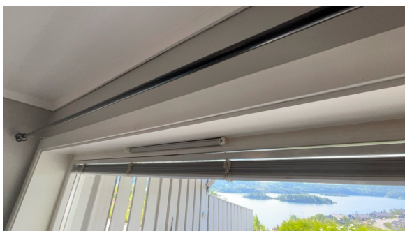
Eksempel på montert ventil i vindu.
