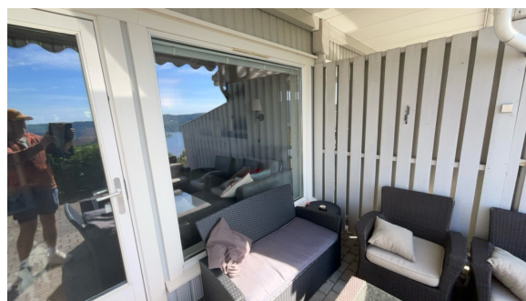
Eksempel på vindu i yttervegg.
