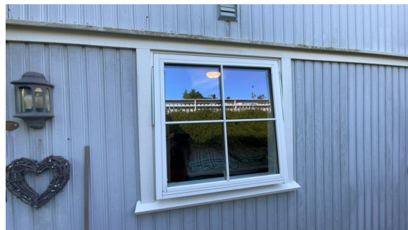
Eksempel på vindu i yttervegg.
