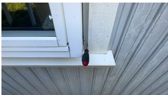
Stikkontroll på vinduer er utført.
