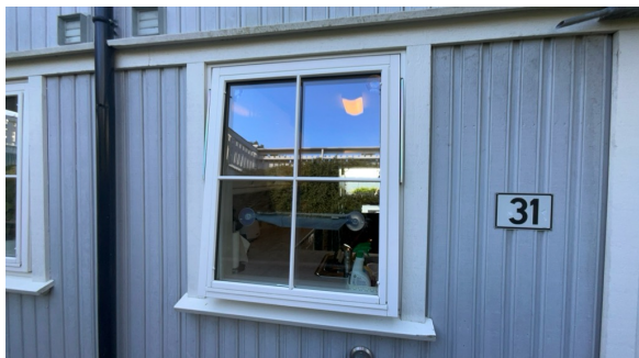
Eksempel på vindu i yttervegg.
