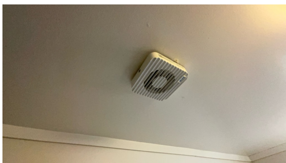
Montert avtrekk i tak.
