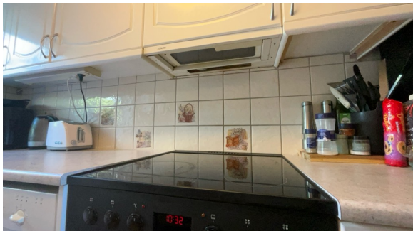
Montert avtrekk over komfyr.
