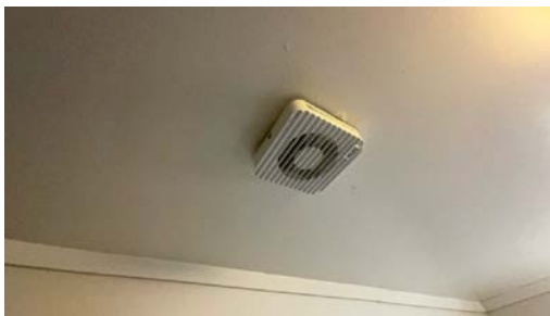
Montert avtrekk i tak.
