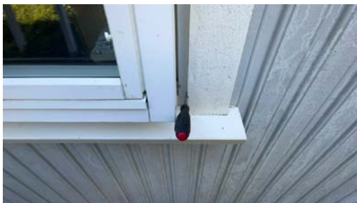
Stikk kontroll på vinduer er utført.
