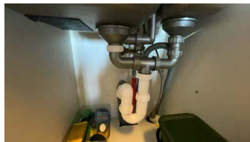
Del av rør til avløp.
