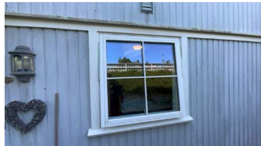
Eksempel på vindu i yttervegg.
