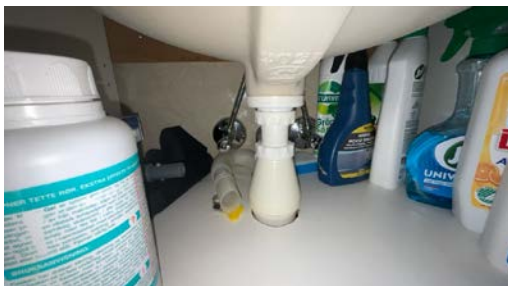
Del av rør til vann.
