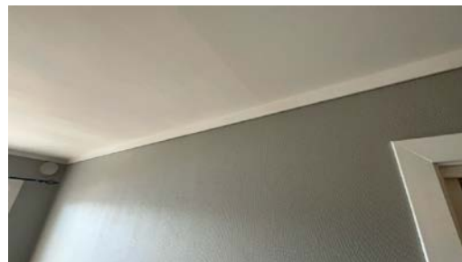
Del av vegg - tak.
