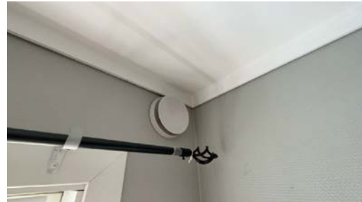
Eksempel på montert ventil i vegg.
