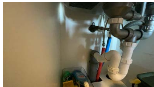
Del av rør til vann.
