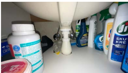
Del av rør til avløp.
