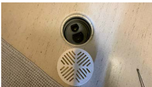
Sluk i gulv.
