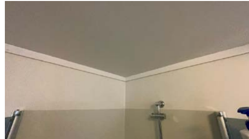
Del av vegg - tak.
