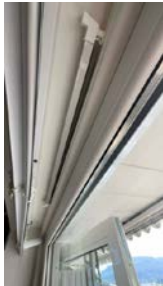
Eksempel på montert ventil i vindu.
