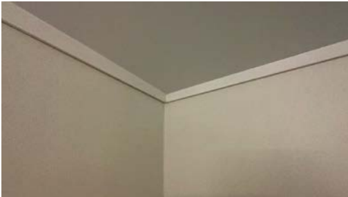
Del av vegg - tak.
