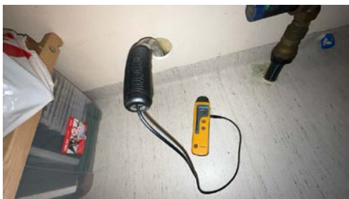
Hull for kontroll av fukt.
