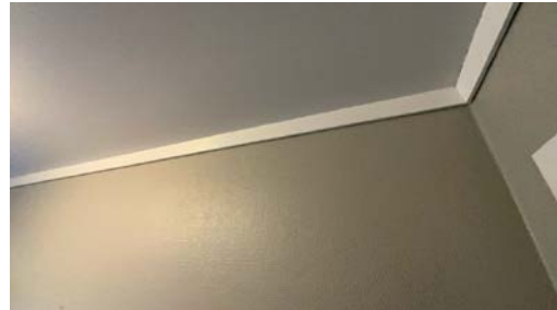
Del av vegg - tak.
