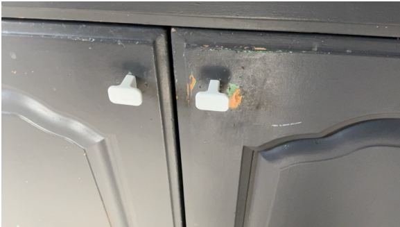
Eksempel på slitasje.
