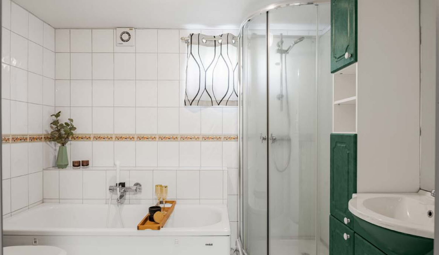
Flislagt bad med varmekabler.
