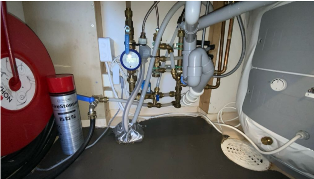
Besiktigelse av røropplegg.
