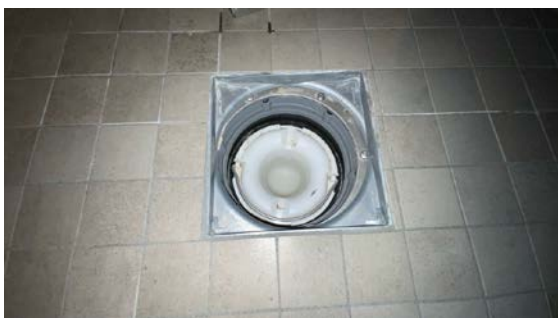
Kontroll av sluk.
